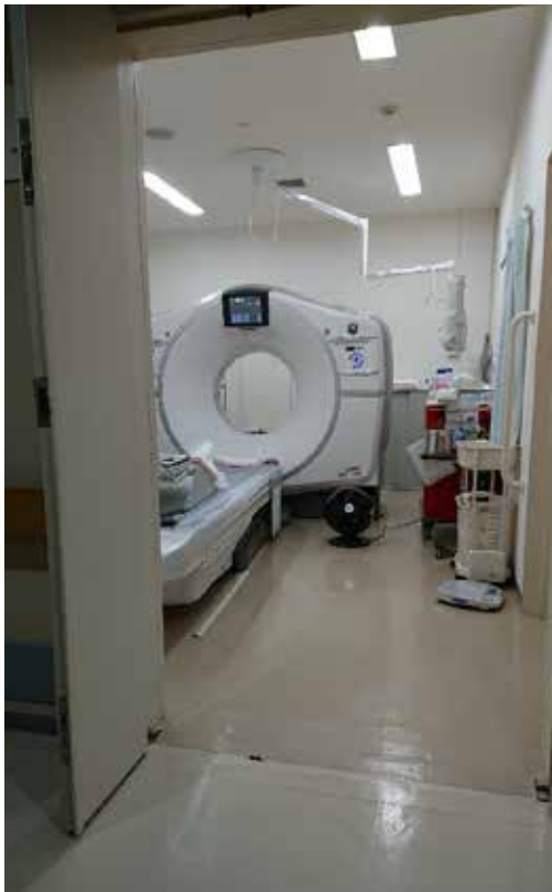
図8 CT検査室の換気状態
